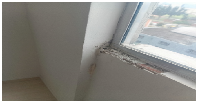
Detalle de acabados
