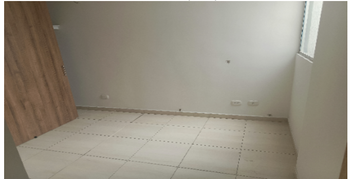
Puerta Hab. principal
