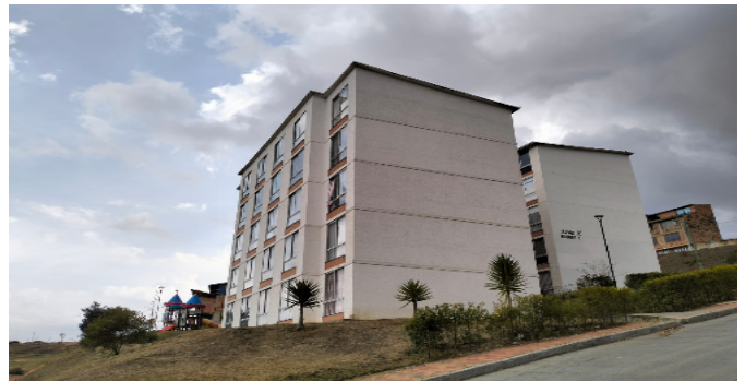
Fachada del Inmueble
