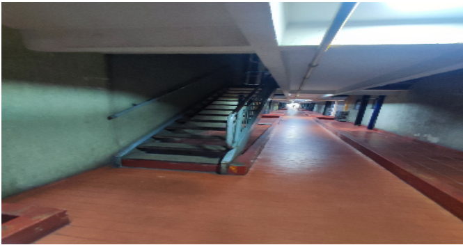
Escalera común - CJ
