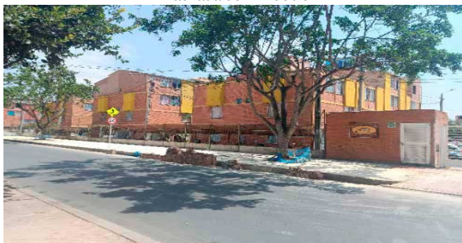
Fachada del Inmueble
