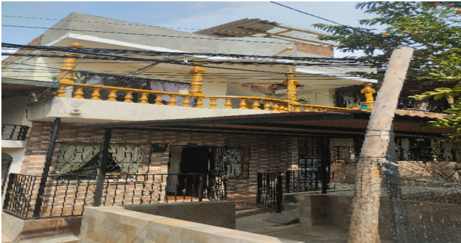
Fachada del Inmueble
