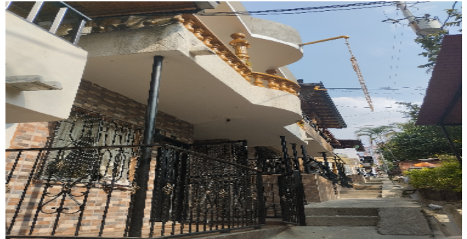
Fachada del Inmueble
