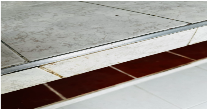
Detalle de acabados
