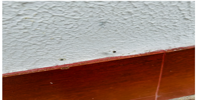
Detalle de acabados
