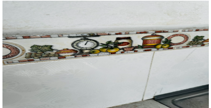
Detalle de acabados
