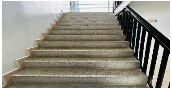
Escalera común - CJ
