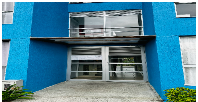
Fachada del Inmueble
