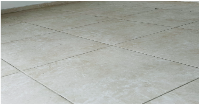
Detalle de acabados
