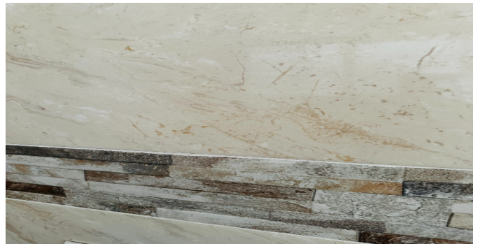
Detalle de acabados
