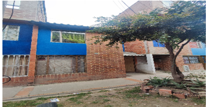
Fachada del Inmueble
