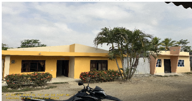
Fachada del Inmueble
