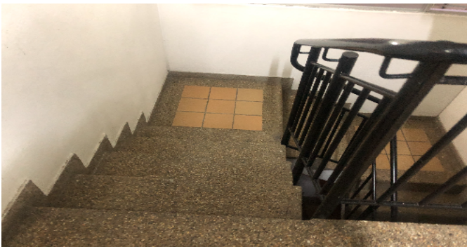
Escalera común - CJ
