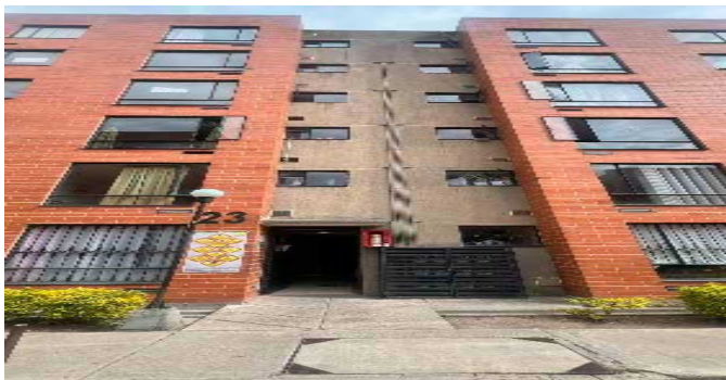
Fachada del Inmueble
