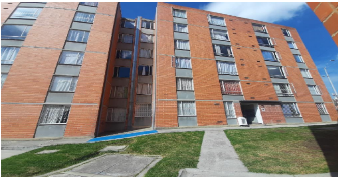
Fachada del Inmueble
