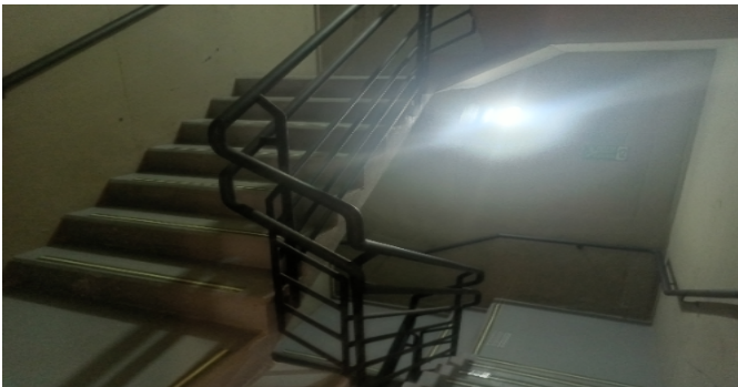
Escalera común - CJ
