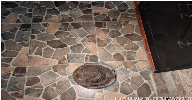
Contador de Agua
