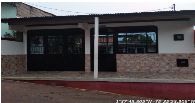
Fachada del Inmueble
