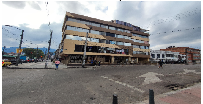
Fachada del Conjunto
