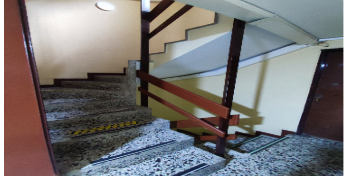
Escalera común - CJ
