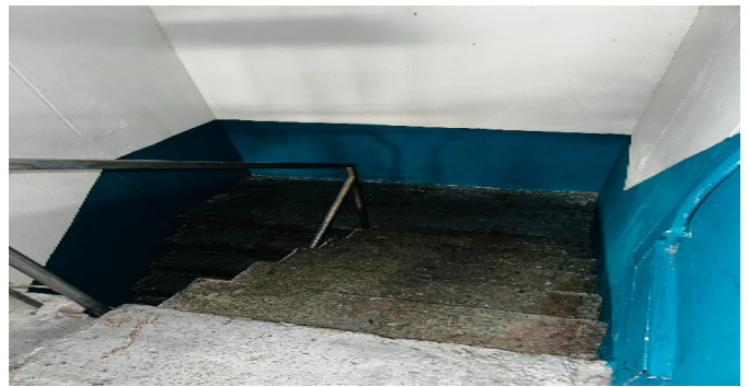
Escalera común - CJ
