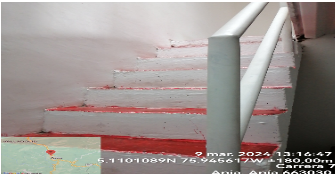
Escalera del inmueble
