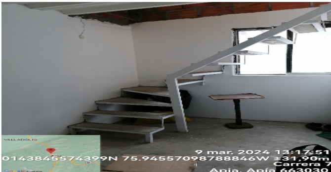
Escalera del inmueble
