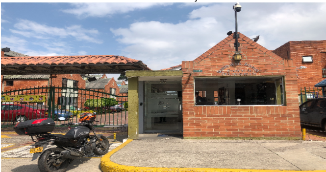
Fachada del Conjunto
