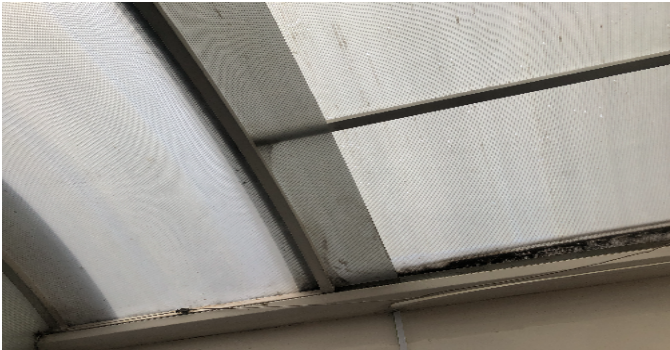
Detalle de acabados
