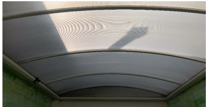
Detalle de acabados
