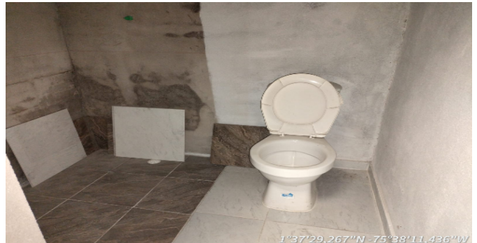
Baño Privado Hab 1
