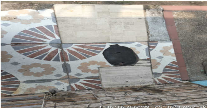
Contador de Agua
