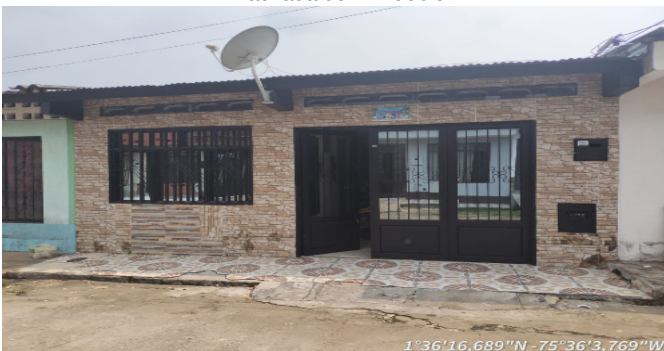
Fachada del Inmueble
