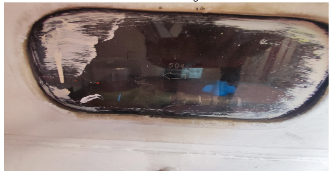
Contador de Agua
