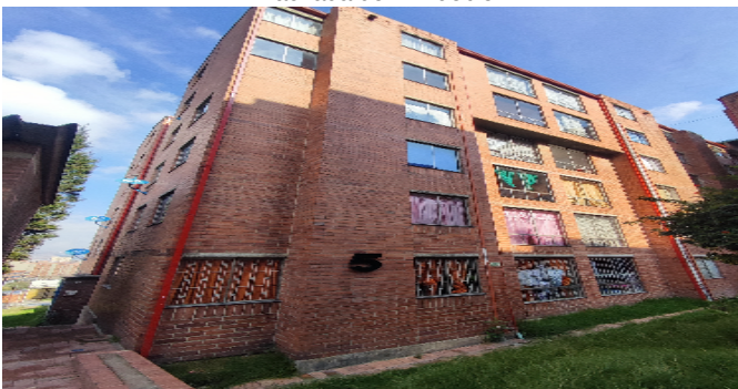
Fachada del Inmueble
