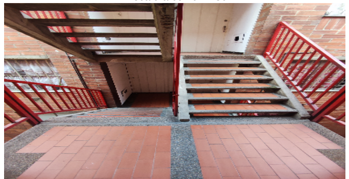
Escalera común - CJ
