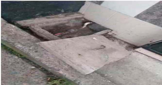
Contador de Agua
