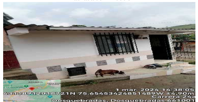
Fachada del Inmueble
