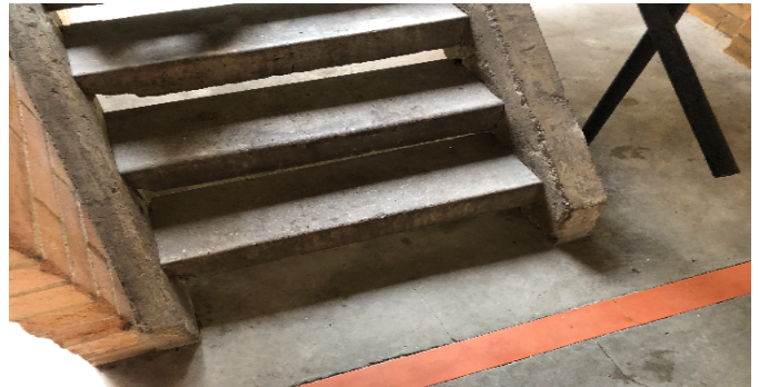
Escalera común - CJ
