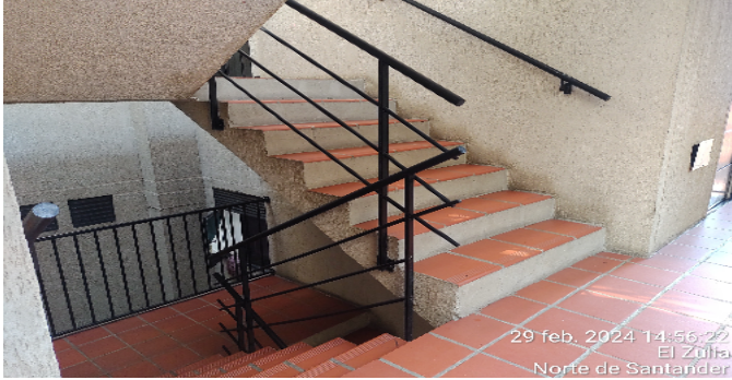
Escalera común - CJ
