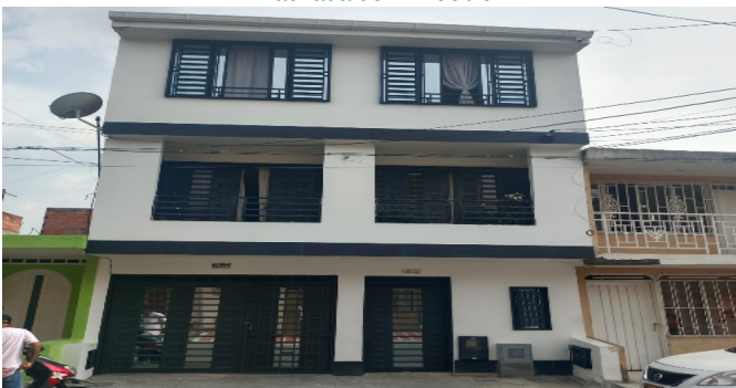
Fachada del Inmueble
