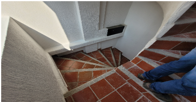
Escalera común - CJ
