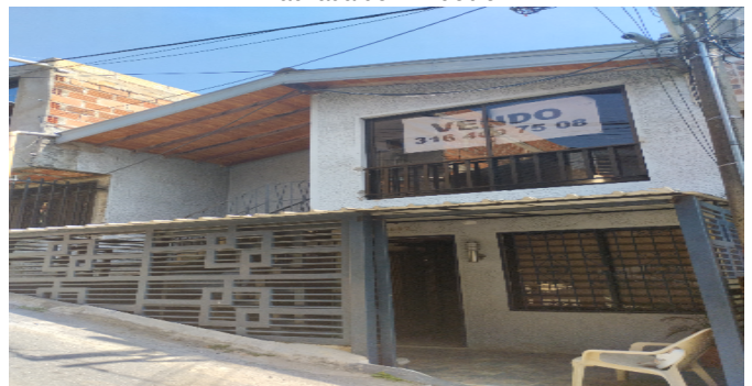
Fachada del Inmueble
