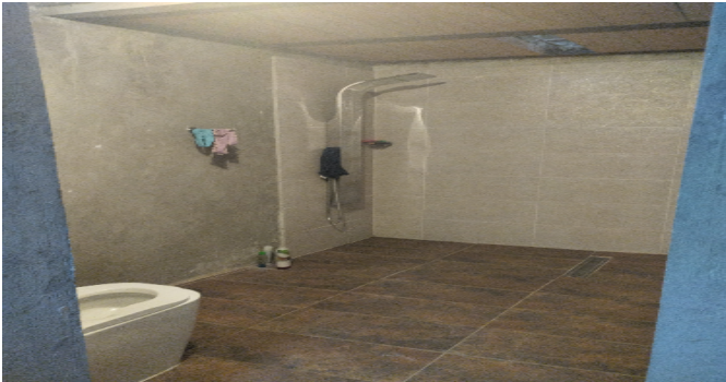
Baño Privado Hab 1
