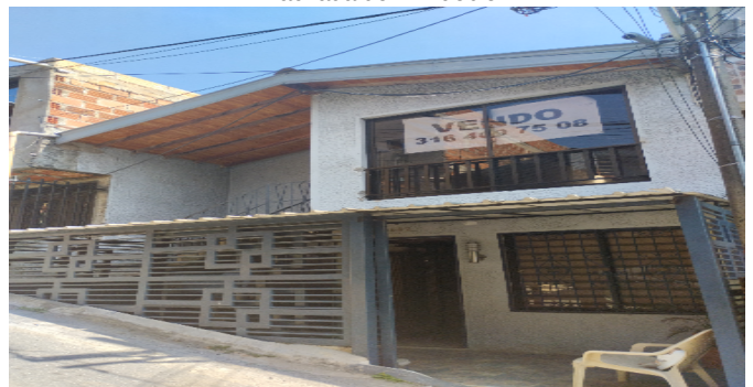
Fachada del Inmueble
