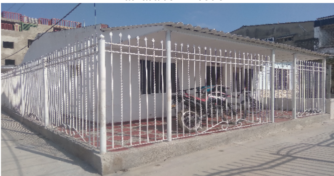
Fachada del Inmueble
