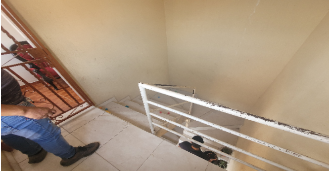
Escalera común - CJ
