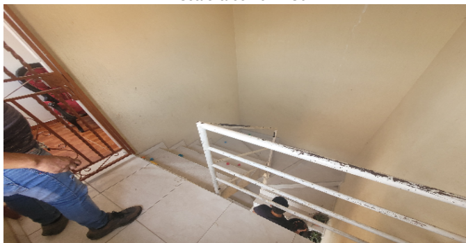
Escalera común - CJ
