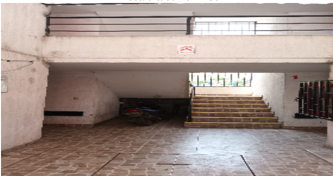
Escalera común - CJ
