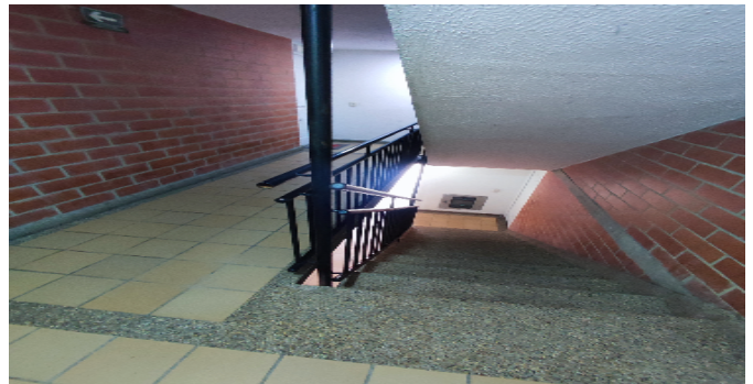
Escalera común - CJ
