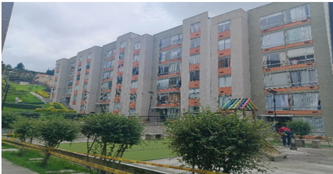
Fachada del Inmueble
