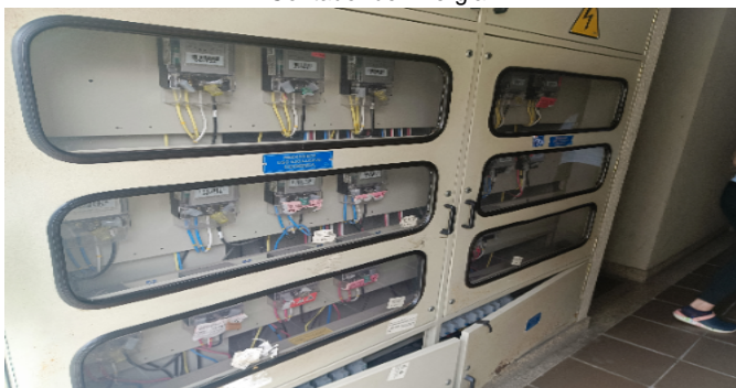
Contador de Energía
