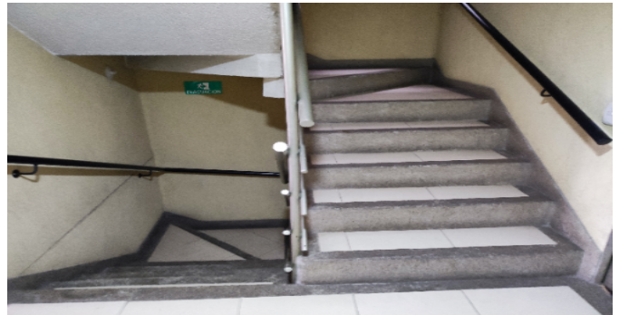
Escalera común - CJ
