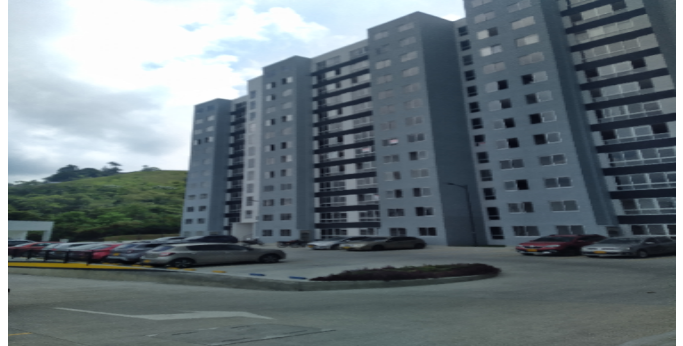
fachada de la torre
