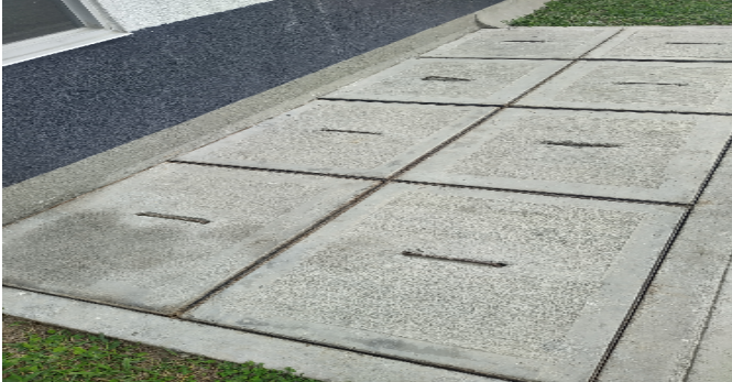
Contador de Agua
