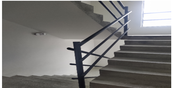
Escalera común - CJ
