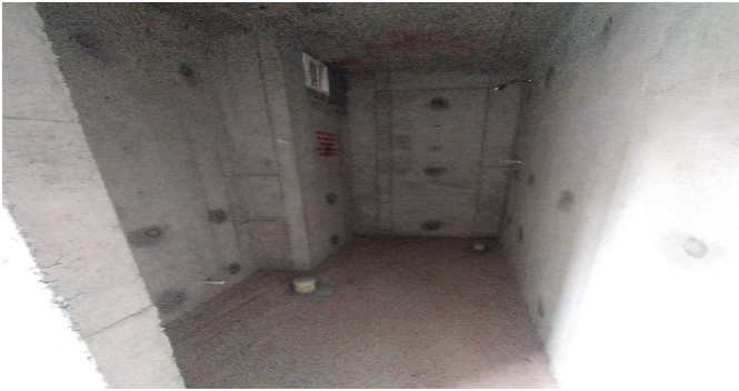
Baño Privado Hab 1
