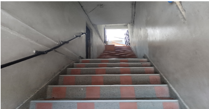
Escalera del inmueble
