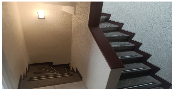
Escalera del inmueble
