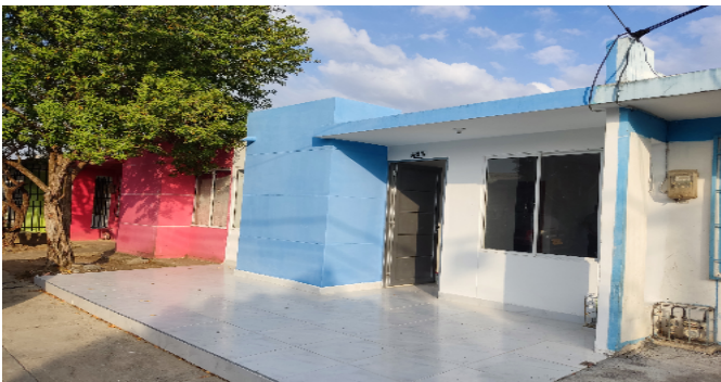
Fachada del Inmueble
