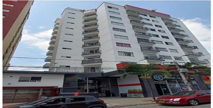
Fachada del Inmueble
