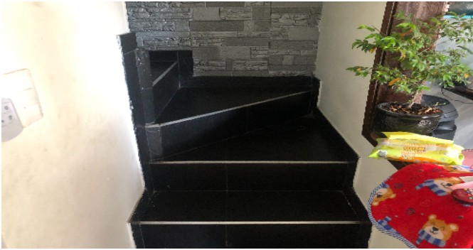
Escalera del inmueble
