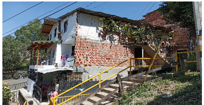
Fachada del Inmueble
