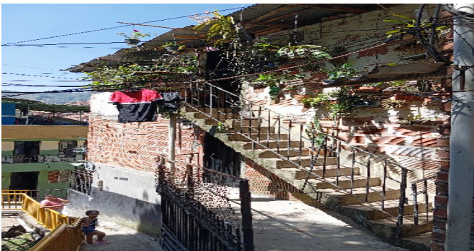
Fachada del Inmueble
