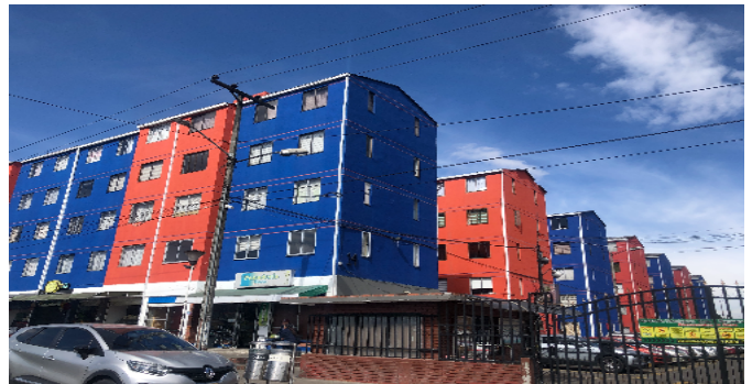
Fachada del Inmueble
