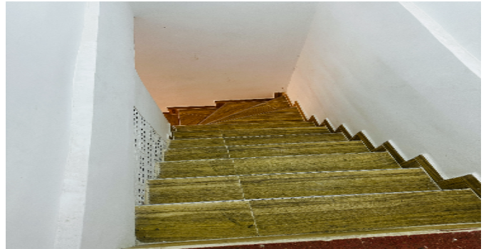
Escalera del inmueble
