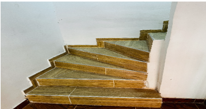
Escalera del inmueble
