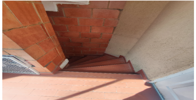
Escalera común - CJ
