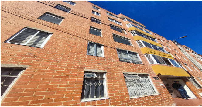
Fachada del Inmueble
