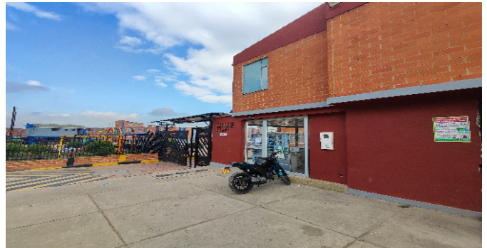
Fachada del Inmueble
