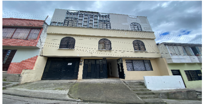
Fachada del Inmueble
