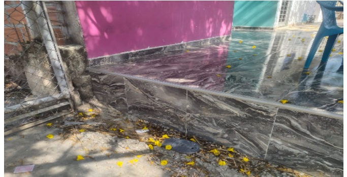
Contador de Agua
