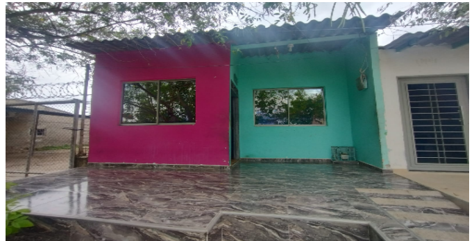
Fachada del Inmueble
